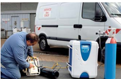
Utilisation du Mobixane™ pour travaux d'entretiens en zone urbaine
